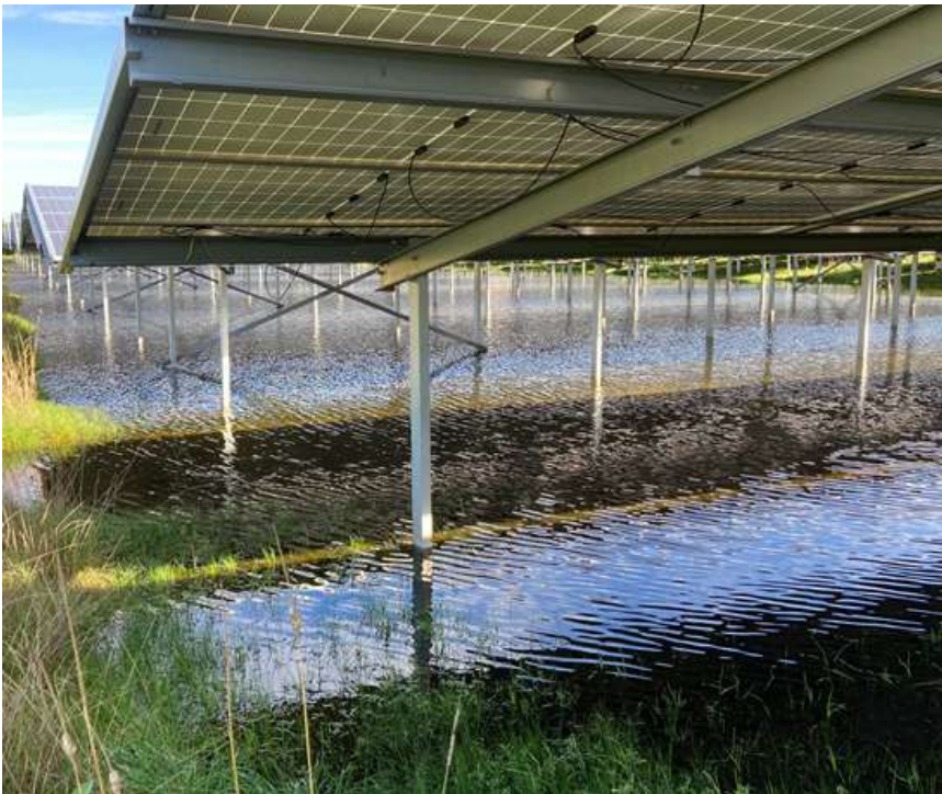
Figuur 15: Voorbeeld van waterbergingsgebied onder zonnepanelen
