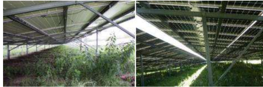
Figuur 4 Links: monofacial panelen met wit kunststof onder de cellen, rechts: bifacial panelen met afstand tussen de cellen.
